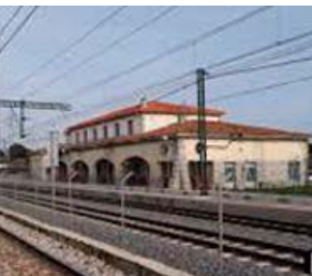
Estación de cercanías de El Goloso
