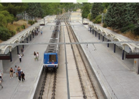
Estación de Lago, una de las más emblemáticas de la Línea 10 en Casa de Campo
