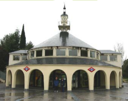
Estación de Lago
