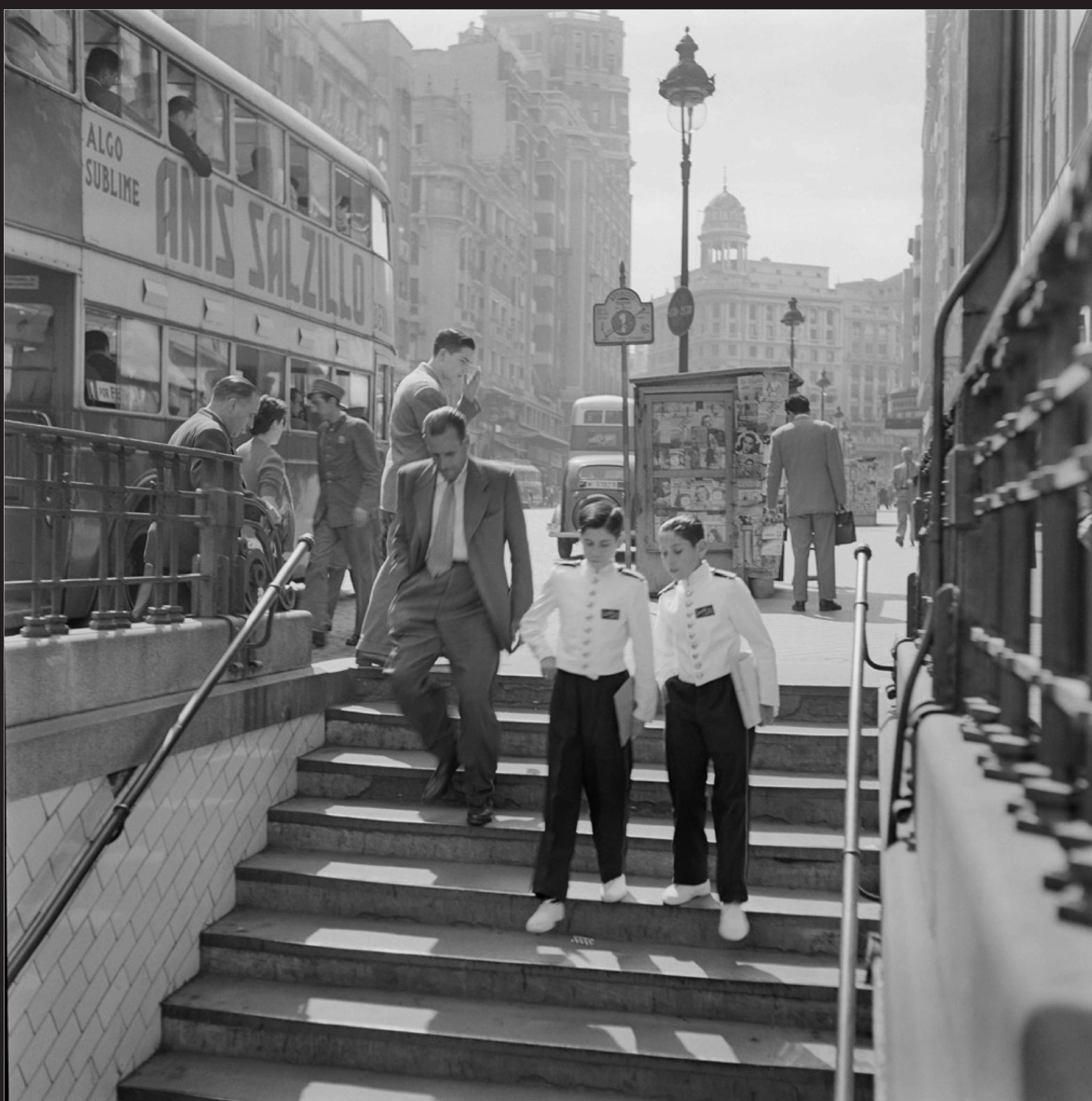
Estación de metro de Santo Domingo de la línea 2. Acceso Gran Vía. El autobús es un Leyland Titan OPD2 de la línea 1 (barrada). (circa 1954).
