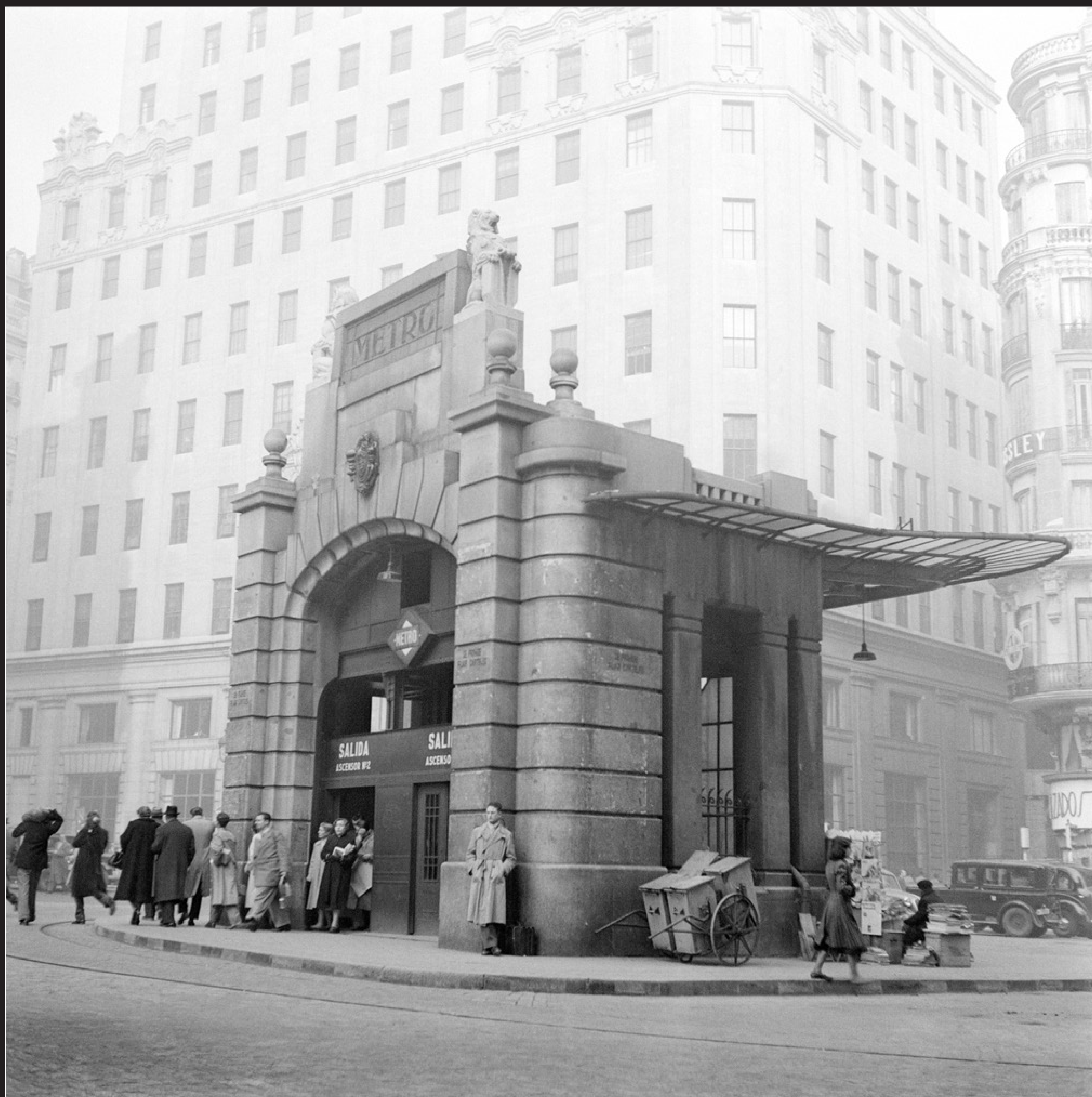
Edificio de acceso a la estación de metro de José Antonio de la línea 1. Bautizada en 1919 como Gran Vía la estación recuperará su denominación actual en 1983. (circa 1954).
