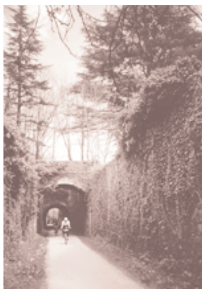
Recuperación de antiguos túneles ferroviarios
