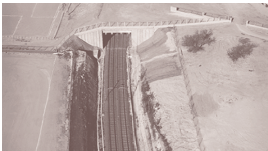
Soterramiento de la vía en el entorno de la estación de Rivas-Urbanizaciones
