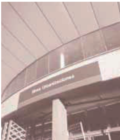
Detalle de la fachada de la estación de Rivas Urbanizaciones
