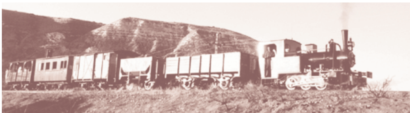
Composición histórica rehabilitada en los años noventa del S.XX por C.I.F.V.M.
