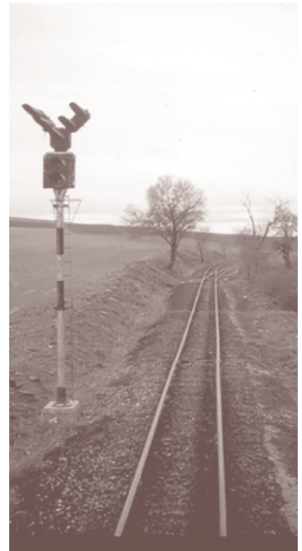
Tramo del Ferrocarril de Portland Valderrivas a su llegada al Alto de Morata (1996)
