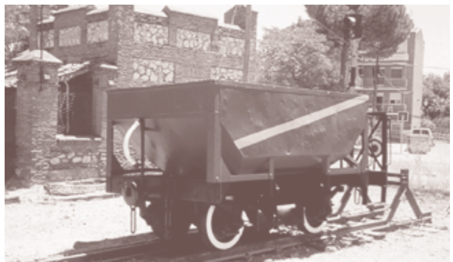
Tolva de mineral rehabilitada en la estación de La Poveda
