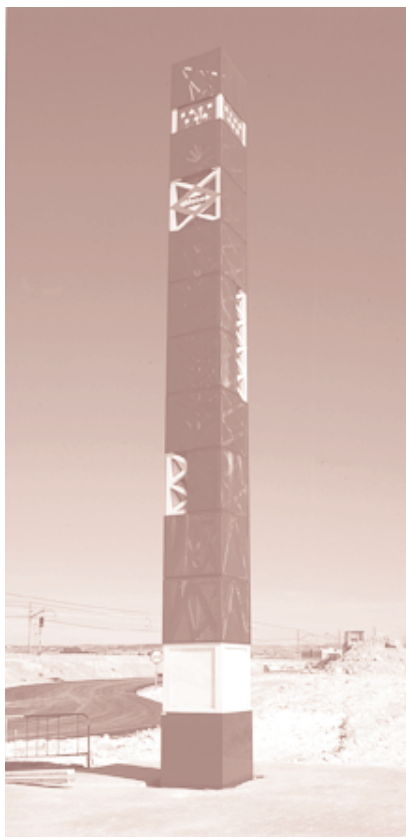
Hito de señalización de estación de la prolongación de línea 9 de metro
