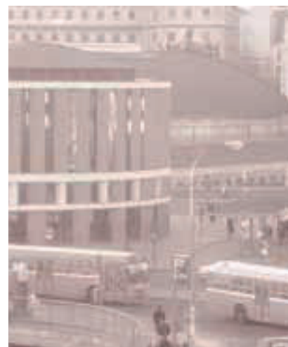
Detalle de autobuses en el Intercambiador de Atocha
