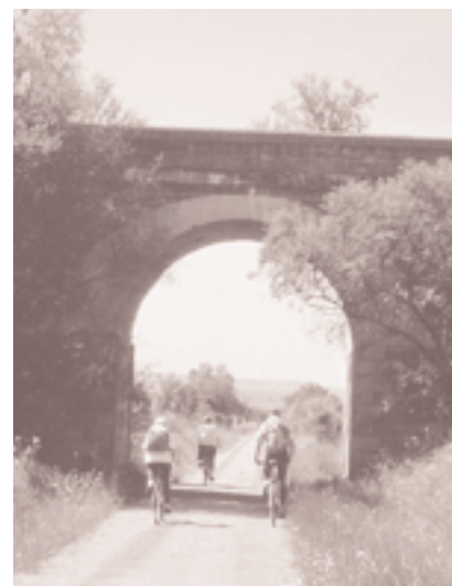
Durante nuestro recorrido encontramos interesantes obras públicas
