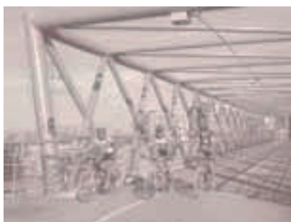
Diversas pasarelas a distinto nivel permiten que el Anillo Verde cruce sobre las grandes infraestructuras viarias
