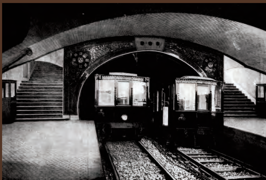
Estación de Progreso, actual Tirso de Molina Progreso station, today called Tirso de Molina
