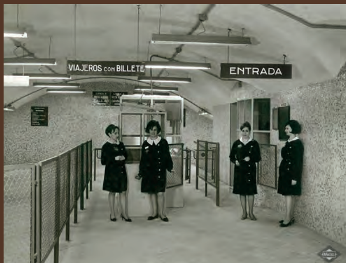
Vestibulo de la estación de Vista Alegre. Nueva línea 5 de Metro. 1968
