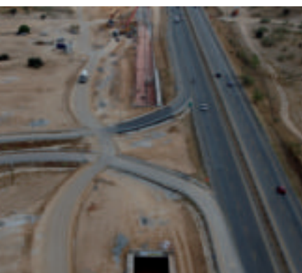
Figura 8: Cruce con la M-40
