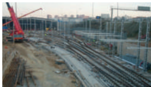
Figura 13: Nave de estacionamiento de las cocheras
