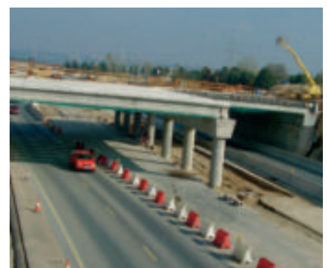
Figura 10: Pérgola sobre la carretera M-503
