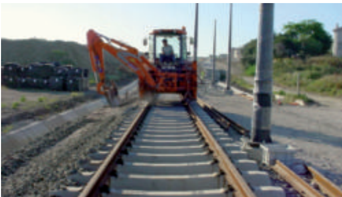
Figura 21: Montaje de vía en balasto (Fase I). Zona La Pañoleta
