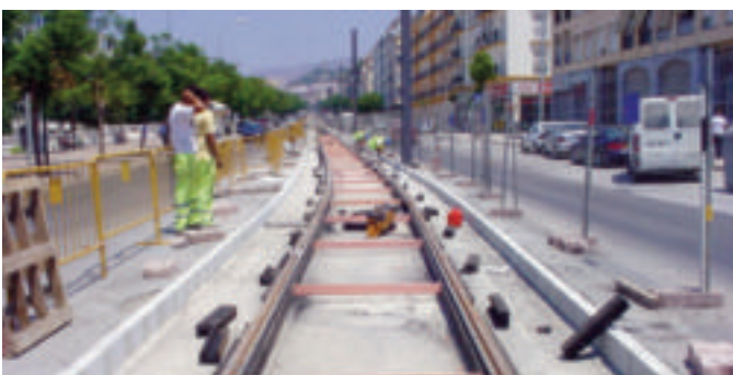
Figura 22: Montaje de vía en placa (Fase I)
