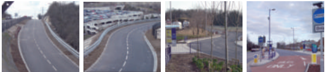
Figura 58: Segregación de la plataforma del Fastrack
