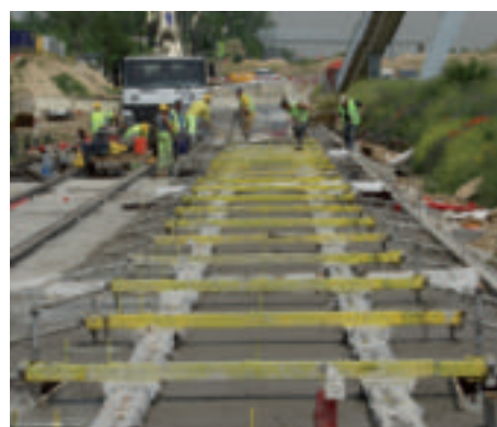
Figura 9: Montaje de vía
