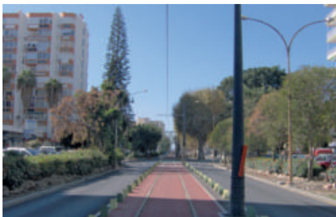
Figura 24: Vía en placa terminada (Torre del Mar)
