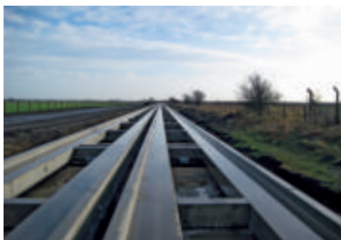
Figura 66: Detalle de la vía de guiado
