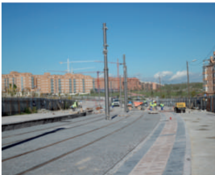
Figura 12: Estado actual de las obras en el tramo I
