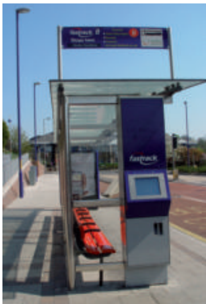
Figura 55: Marquesina de las estaciones de Fastrack
