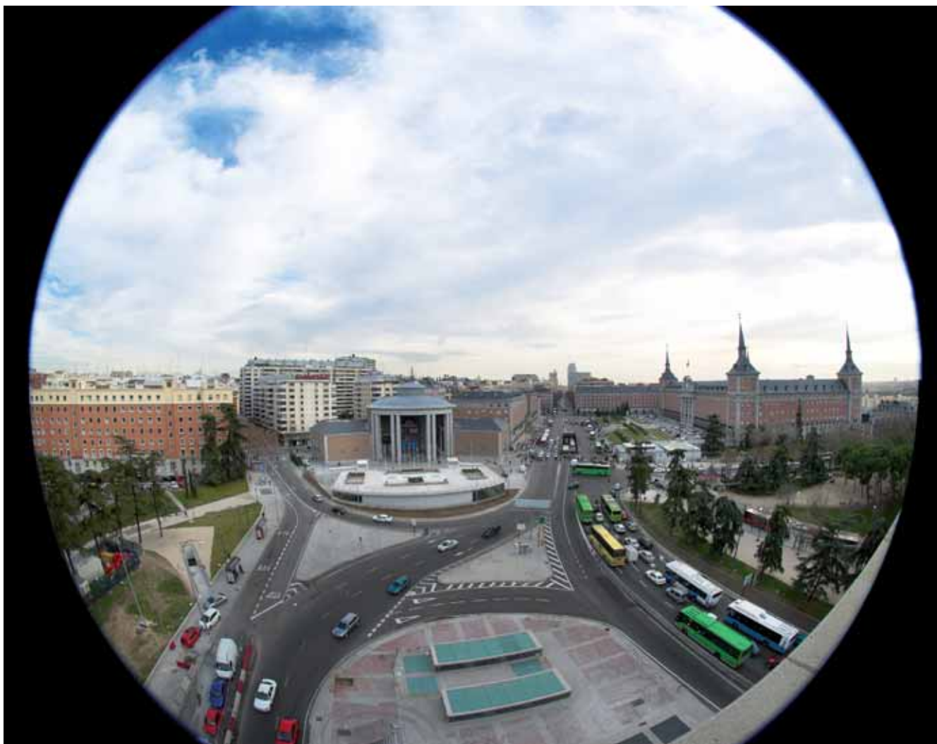
Lucernarios y ventilación en plaza del Arco Light wells and ventilation in the Arch plaza
