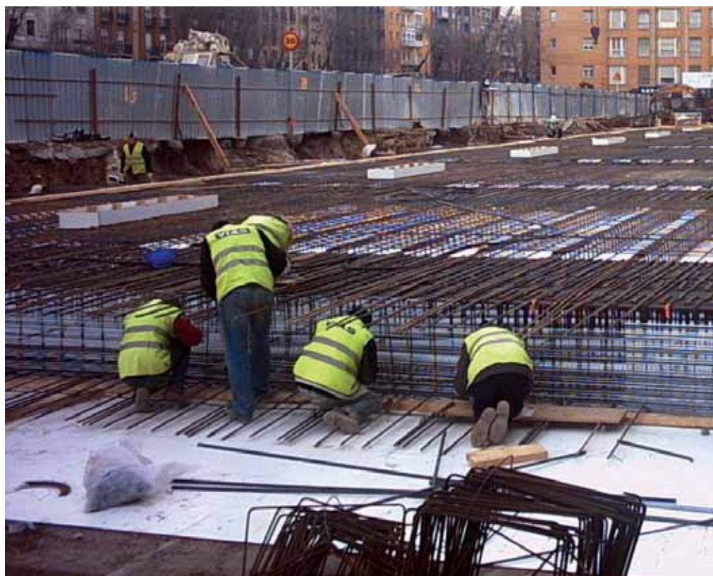
Ejecución losa de cubierta / Execution of the roof slab
