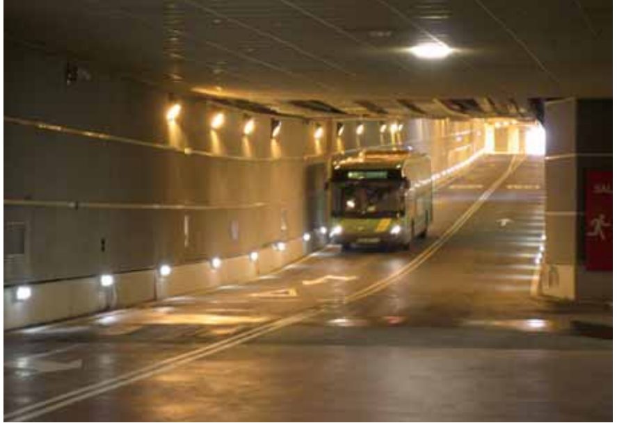
Túnel de acceso Access tunnel
