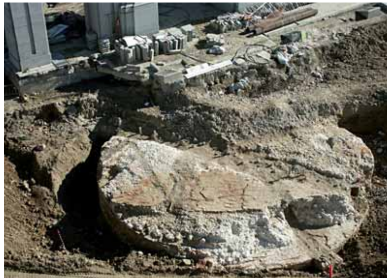
Vista aérea de la cimentación de la Fuente de los Mascarones Aerial view of the foundation of the Fuente de los Mascarones
