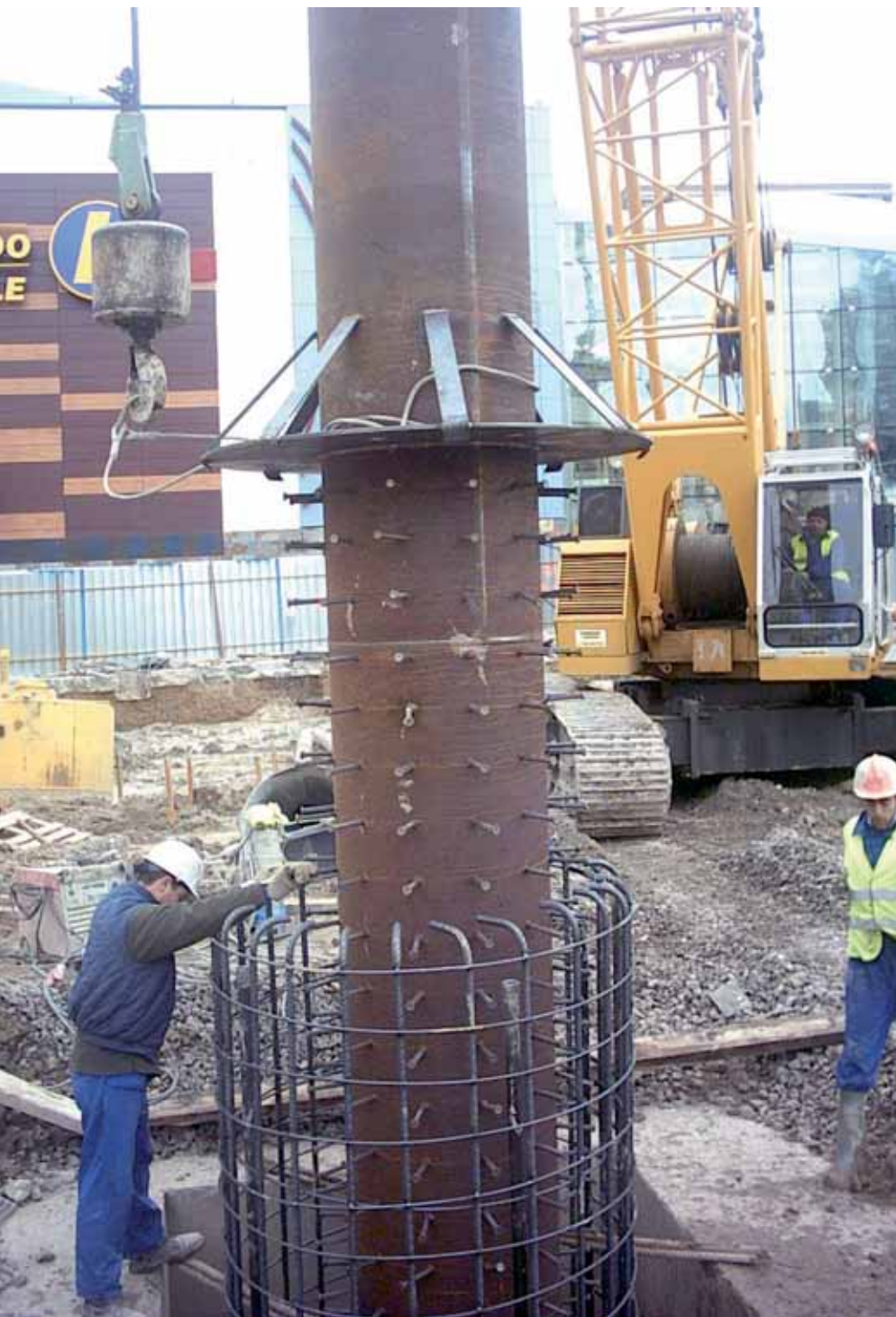
Pila pilote / Pile pier
