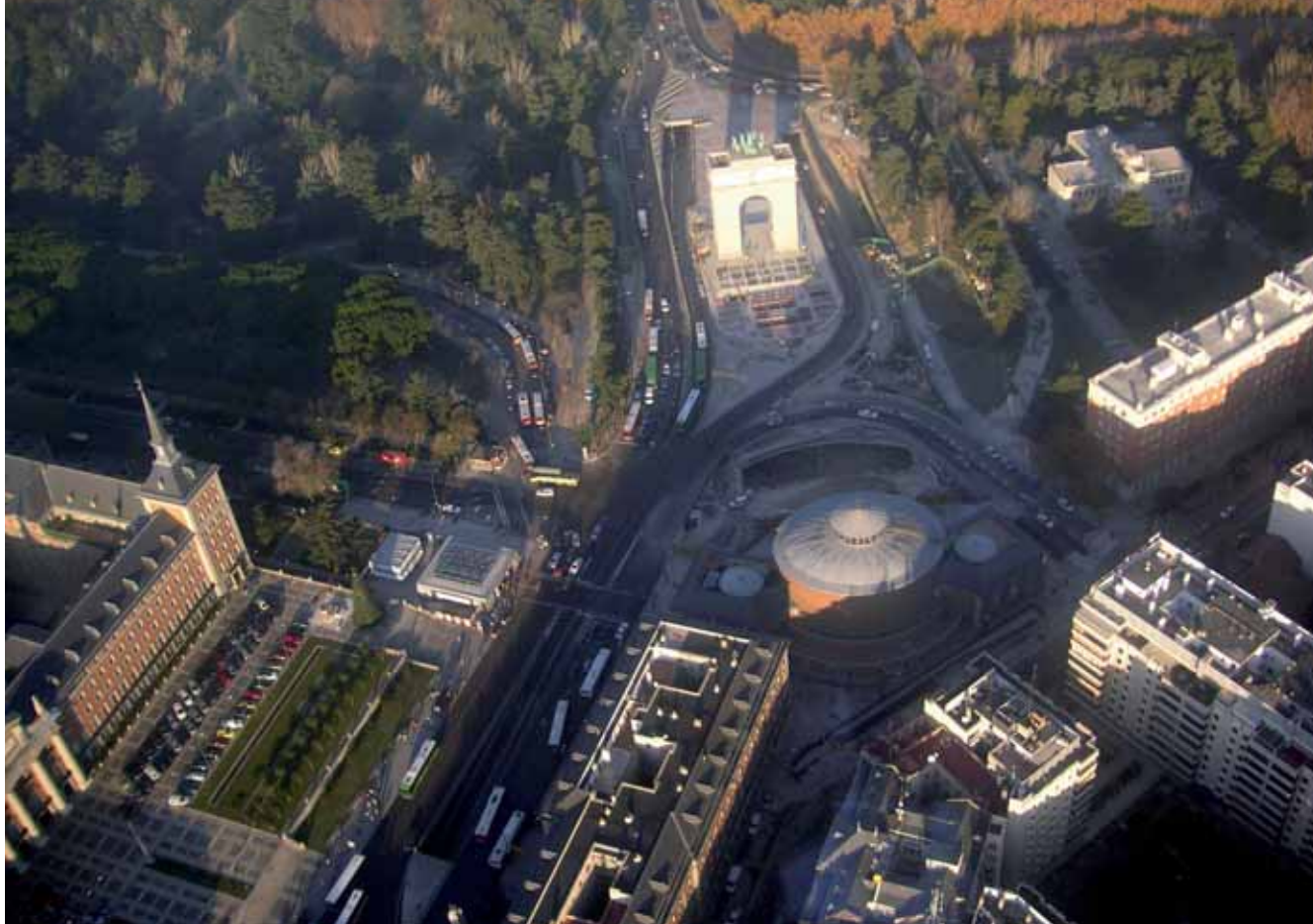
Vista aérea del entorno de la obra. Diciembre 2006 Aerial view of the surroundings of the site. December 2006
