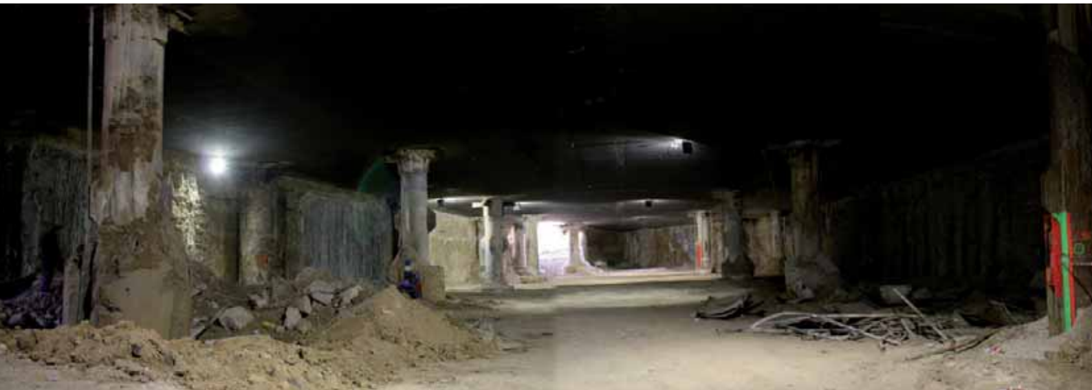
Excavación entre pantalla línea 6 y nueva pantalla parque del Oeste. Agosto 2006
