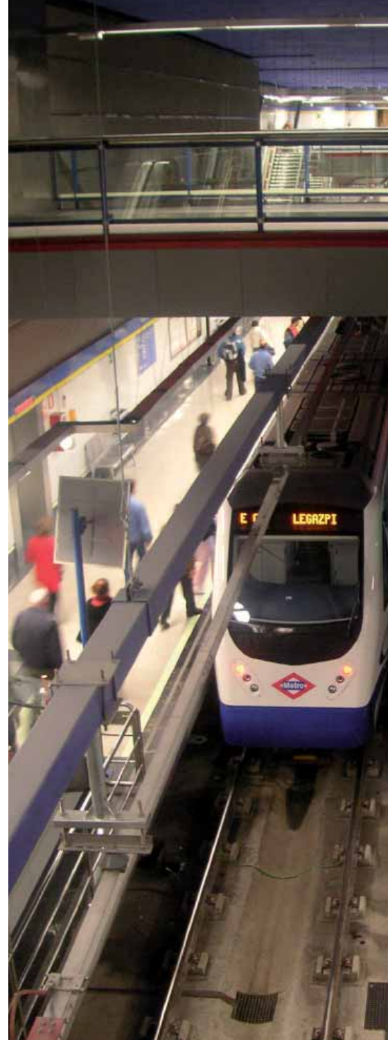
Nuevo andén línea 3 Metro Moncloa New line 3 Metro platform in Moncloa
