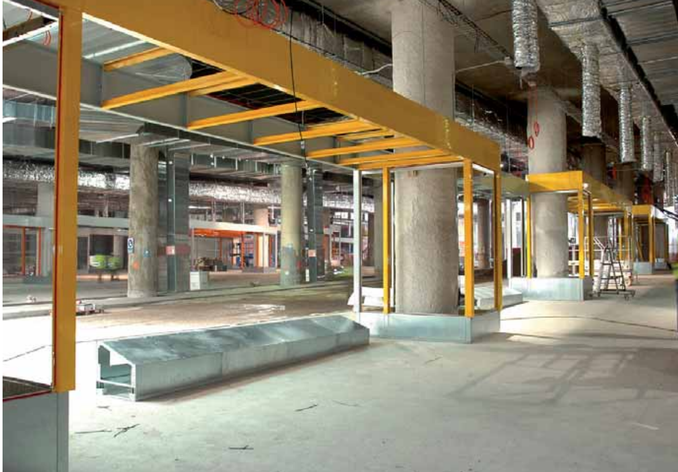
Montaje mamparas e instalaciones en islas. Septiembre 2007 / Erection of screens and installations in islands. September 2007
