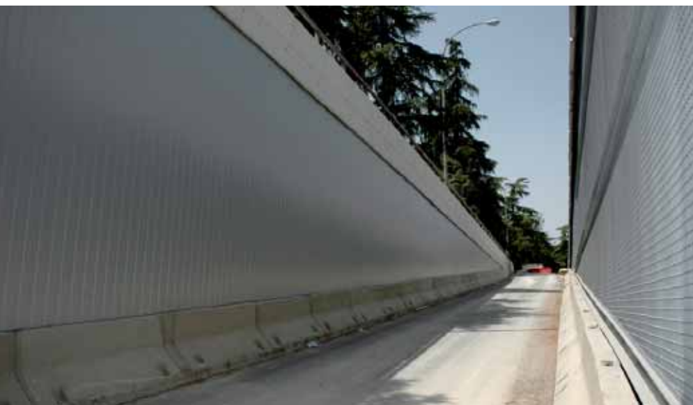
Rampa de acceso lateral oeste. Septiembre 2007 Western access ramp. September 2007
