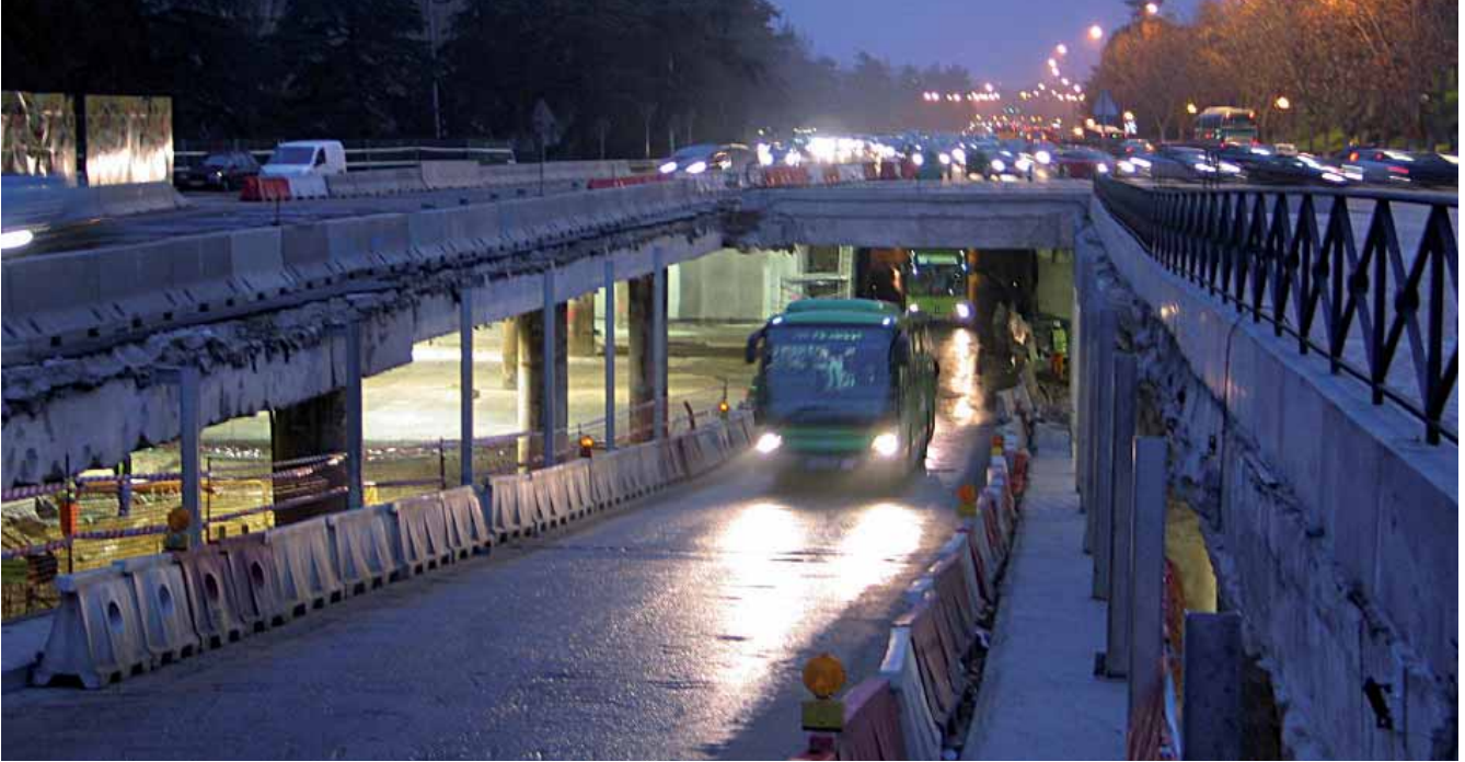
Rampa Bus-Vao. Febrero 2007 / Bus-HOV ramp. February 2007
