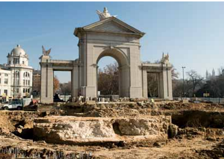
Vista de la cimentación de la Fuente de los Mascarones y la actual Puerta de San Vicente View of the foundation of the Fuente de los Mascarones and the current Puerta de San Vicente
