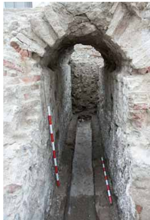
Viaje de agua localizado en el interior de la cimentación de la Fuente The water's route located in the interior of the fountain's foundation
