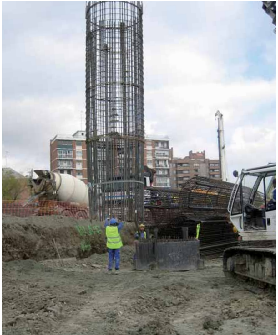
armadura de cimentación-pilote / reinforcement of pile foundations
