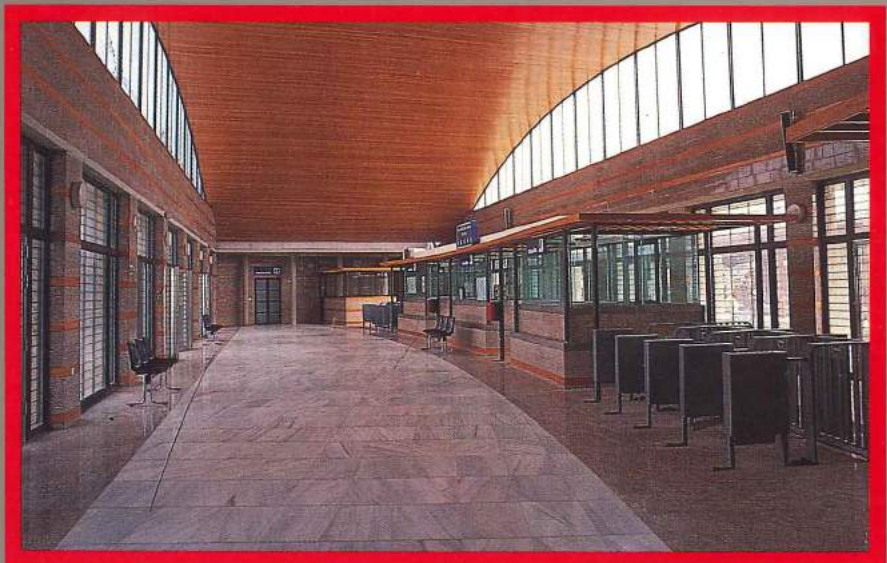
Nueva estación de cercanías de RENFE en Fuenlabrada e intercambiador de transporte.
