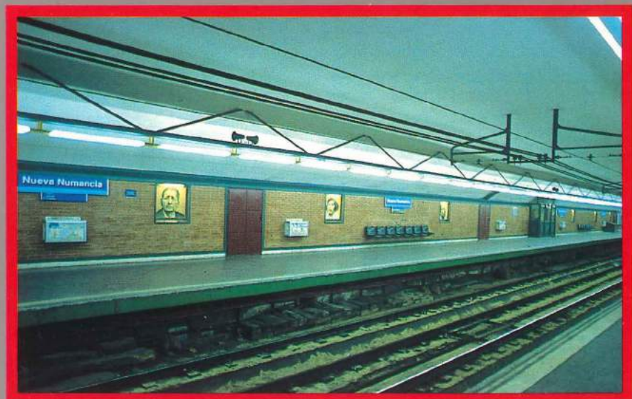
La estación de Nueva Numancia (línea 1) tras las reformas realizadas en la misma.
