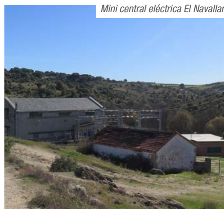
Mini central eléctrica El Navallar
