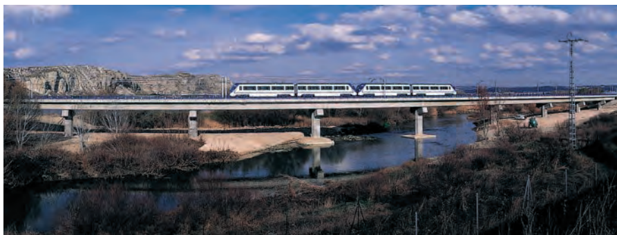
La línea 9 a su paso por el puente sobre el río Jarama
