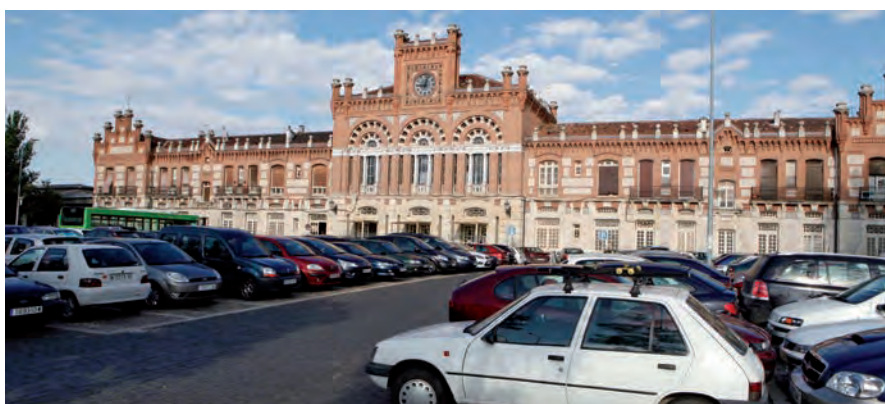
Aparcamiento de disuasión de libre acceso en la estación de Aranjuez
