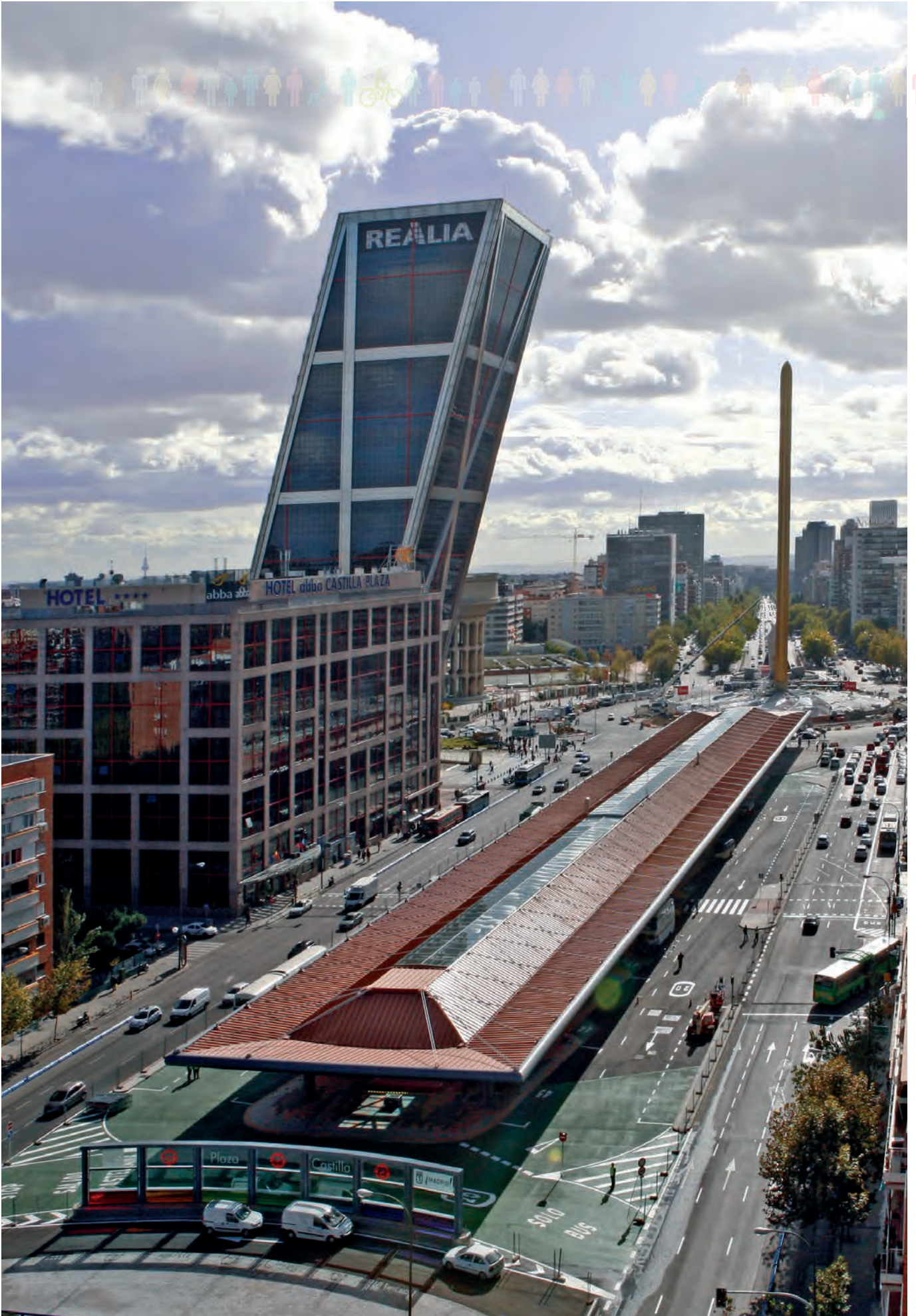
Intercambiador de superficie en Plaza de Castilla
