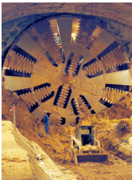
Tuneladora entrando en una estación de Metro
