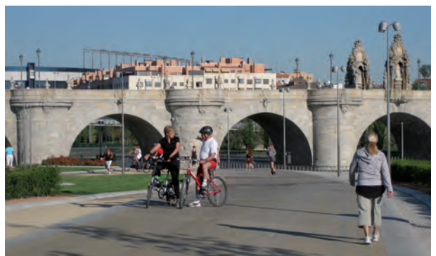
Madrid Río. Puente de Toledo
