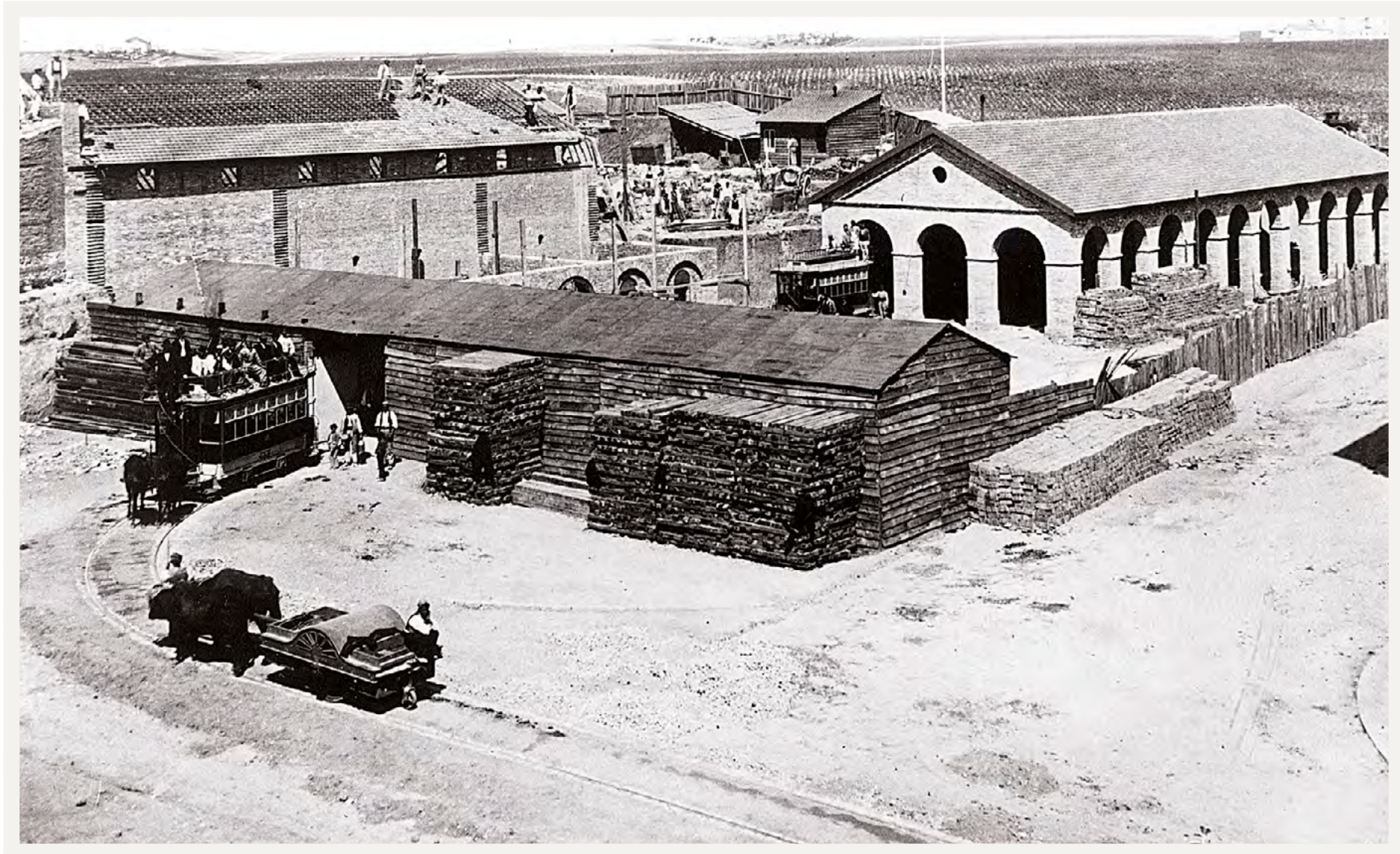
Cochera del barrio de Salamanca en la fase de obras del tranvía. Este edificio se encontraba en Serrano esquina con Maldonado.
