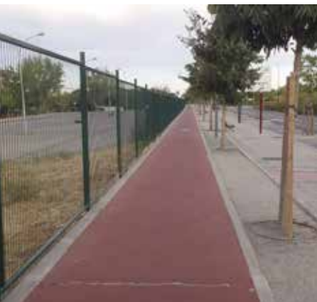
Carril bici Somosaguas
