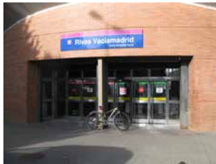
Estación de Rivas Vaciamadrid
