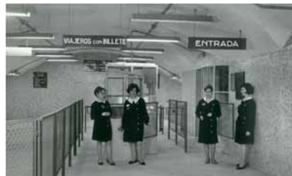
Vestíbulo de acceso a la estación de Vista Alegre (Línea 5).
