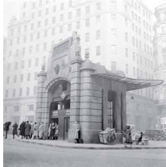
Ascensor de la estación de José Antonio (Gran Vía).
