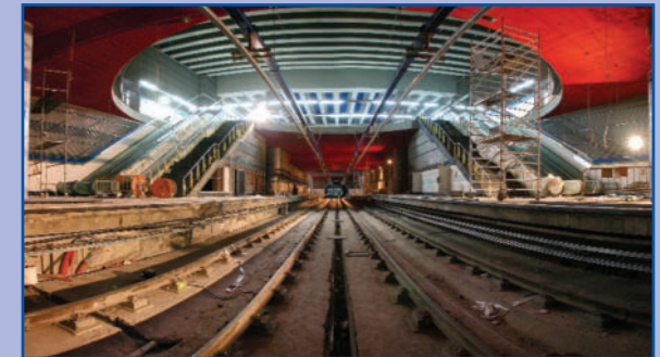
Construcción de una estación en MetroSur
