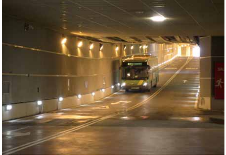
Túnel de acceso Access tunnel
