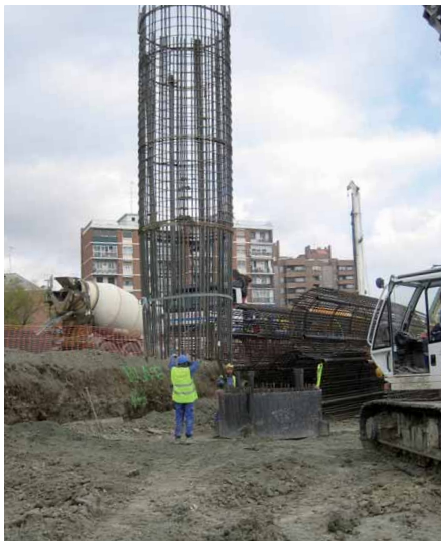
armadura de cimentación-pilote / reinforcement of pile foundations
