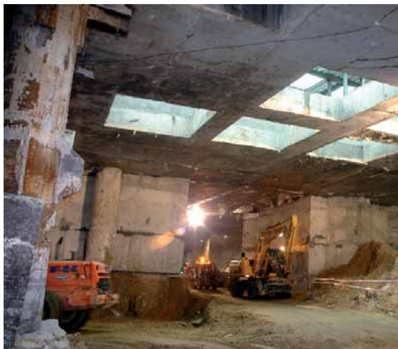
Refuerzo pilas de cimentación del Arco de Triunfo / Reinforcement of foundation piers for the Arco de la Victoria
