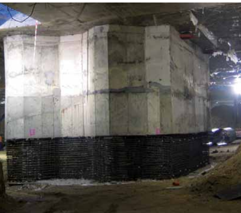
Refuerzo pilas de cimentación del Arco de Triunfo / Reinforcement of foundation piers for the Arco de la Victoria
