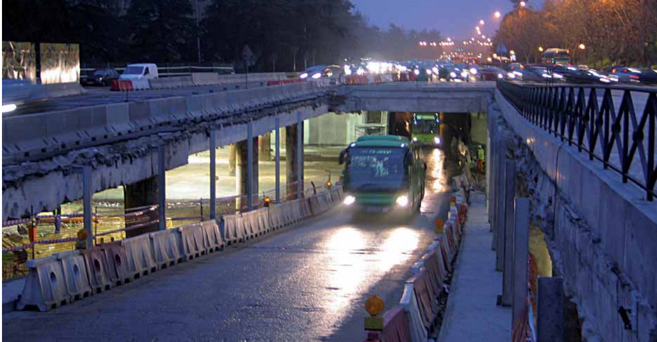
Rampa Bus-Vao. Febrero 2007 / Bus-HOV ramp. February 2007
